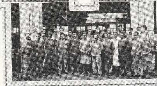
Werkplaatspersoneel der firma Albert Fleury te Genève. Boven links : Een kijkje in de machine-kamer. De deur achter geeft toegang tot het acculaadstation. Boven rechts : Onderdeelen-magazijn; de bins hebben verstelbare vakken, de administratie geschiedt volgens Kardex-systeem.
